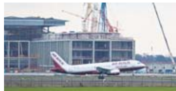
Baustelle: Der neue Airport
